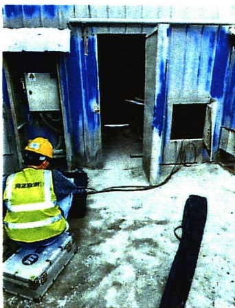
C2线水泥磨排气筒
